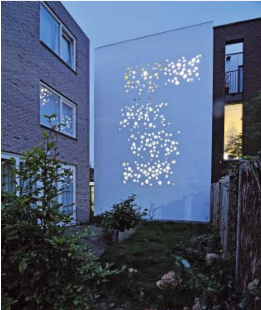
Geheimnisvolles Korallenriff bei Nacht: Betonfassade mit Löchern, die durch Herauskratzen von Schaumstoffelementen nach Austrocknen des Betons entstanden.
